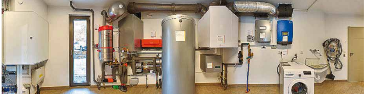
Technikraum-Panorama von links: Sicherungskasten, Zentralstaubsauger, Pufferspeicher, Heizungssteuerung, Warmwasserspeicher, Lüftung, Wechselrichter und Waschmaschine.
