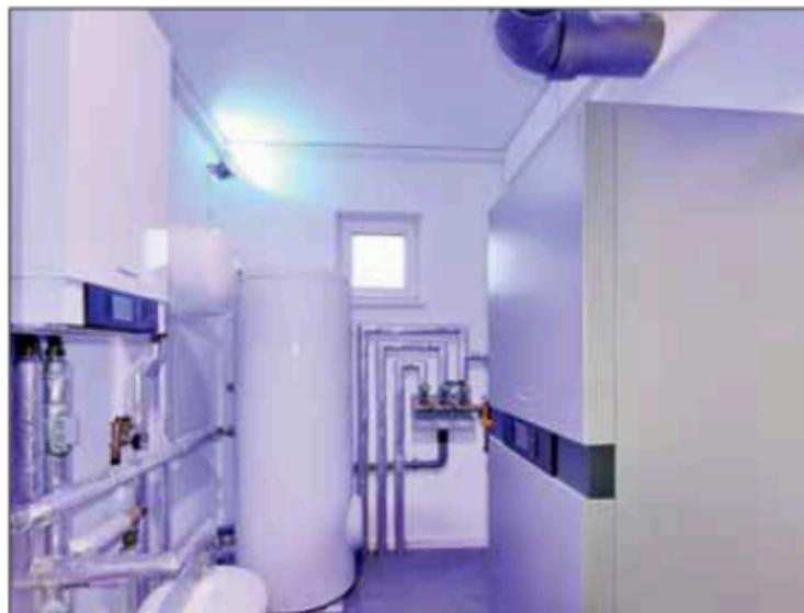
Die gesamte Haustechnik, die bislang einen rund 10 m<sup>2</sup> großen Raum belegt (oben), verschwindet im neuen Viessmann-System in 28 cm tiefen Modulen hinter einer Sichtoberfläche (rechts).
